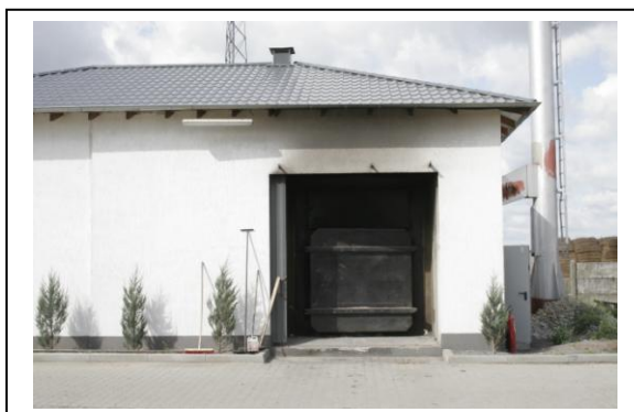
Kotłownia na baloty o mocy 750kW
